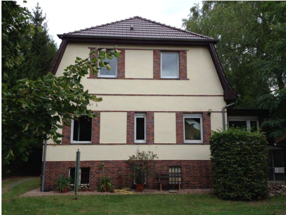
Bild 3: Gebäude mit Aktenzeichen 07539 - Tre - XXTN - 08 W, Außenansicht (Foto von der Ortsbesichtigung am 26. Aug. 2015)
