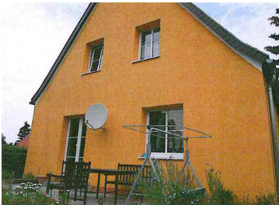
Bild 3: Gebäude mit Aktenzeichen 13442 - Bla - XETN - 10 W, Außenansicht (aus ASE vom 28. August 2014)
