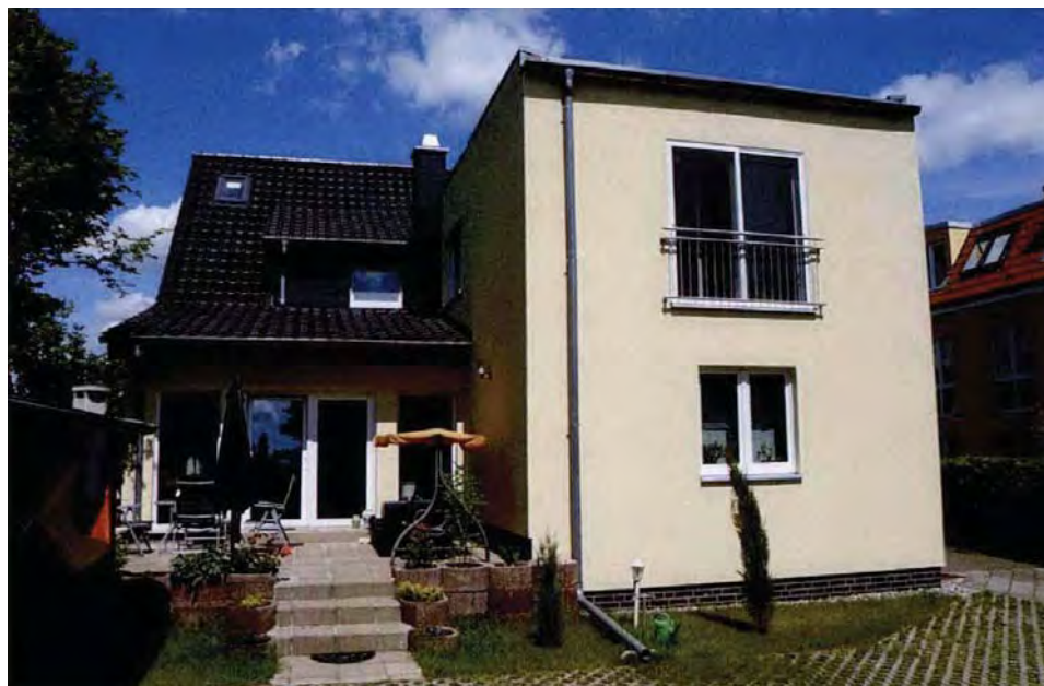
Bild 4: Gebäude mit Aktenzeichen 14148 - Bla - XATN - 10 W, Außenansicht Gartenseite (aus ASE vom 19. Februar 2015)
