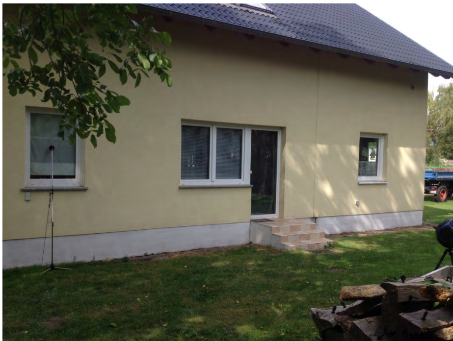
Bild 4: Gebäude mit Aktenzeichen 02879 - Szd - XXTN - 07 W, Außenansicht Einliegerwohnung (links) und Hauptgebäude (Foto von der Ortsbesichtigung am 27. Aug. 2015)
